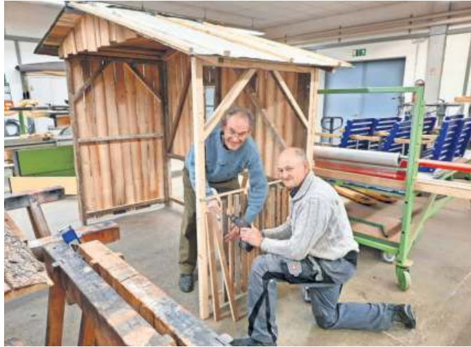
Claus Hempfing (links) und Rainer Lang bei den Arbeiten am „Stall von Bethlehem“, der Teil der Waldweihnacht am Dr.-Köhl-Stein am 15. Dezember sein wird.
